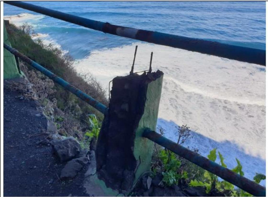
Vista del gran deterioro de otra pilastra de hormigón armado.
