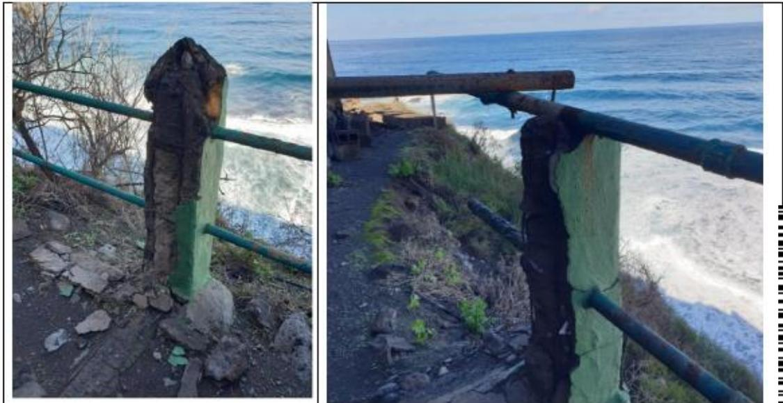
Detalle del estado ruinoso de las pilastras de hormigón armado y de las barandillas de tubo galvanizado
