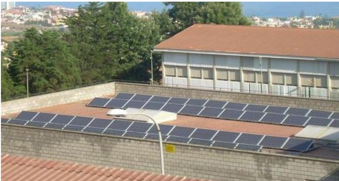
*Imagen de la instalación solar fotovoltaica conectada a red, con potencia de 9 kW, del IES La Orotava-Manuel González Pérez. Fuente: EuropaPress*
