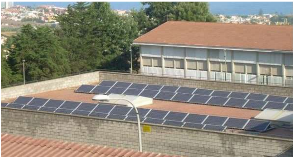
Imagen de la instalación solar fotovoltaica conectada a red, con potencia de 9 kW, del IES La Orotava-Manuel González Pérez. Fuente: EuropaPress
