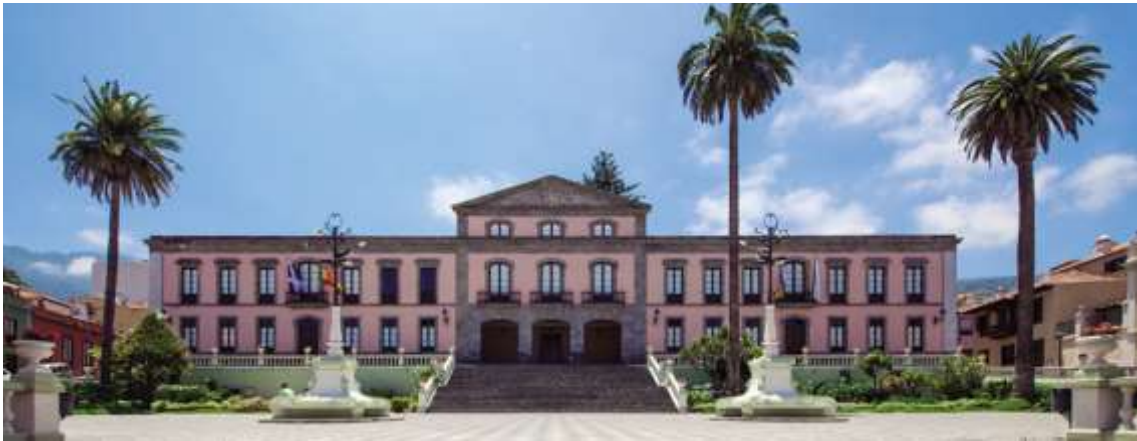
Imagen de la fachada principal de las Casas Consistoriales de La Orotava. Fuente: Ayto. de La Orotava.
