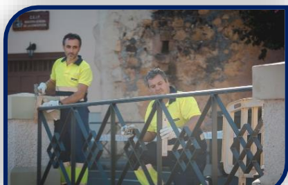
Colocación de baranda, vallas y otros elementos de protección
