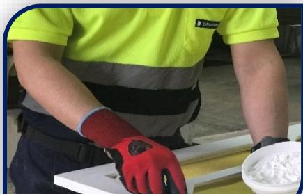
Restauración y mantenimiento de elementos de carpintería
