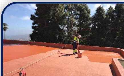
Impermeabilización en cubierta
