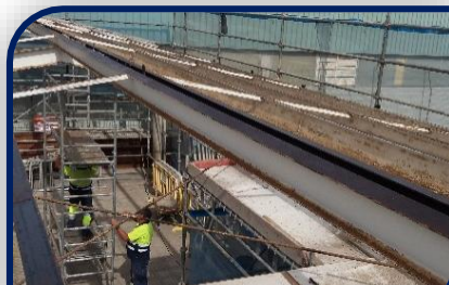
Adecuación de porche en Colegio
