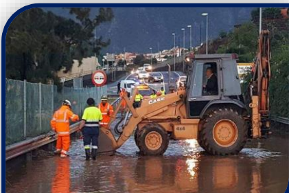
Utilización de maquinaria pesada para solventar las incidencias
