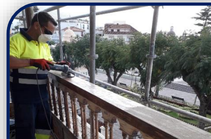
Mantenimiento de madera exterior e interior
