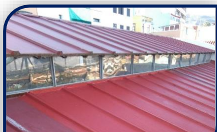
Adecuación de cubierta
