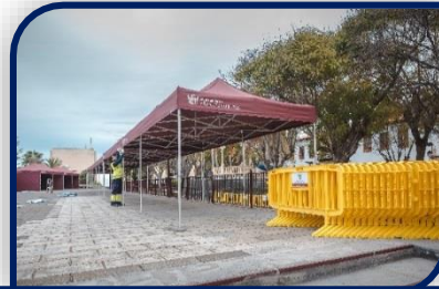
Montaje de carpas
