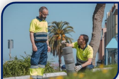
Reparación y renovación de hitos
