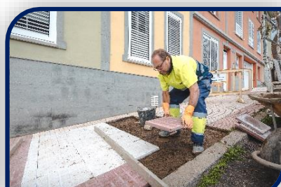
Reparación de aceras
